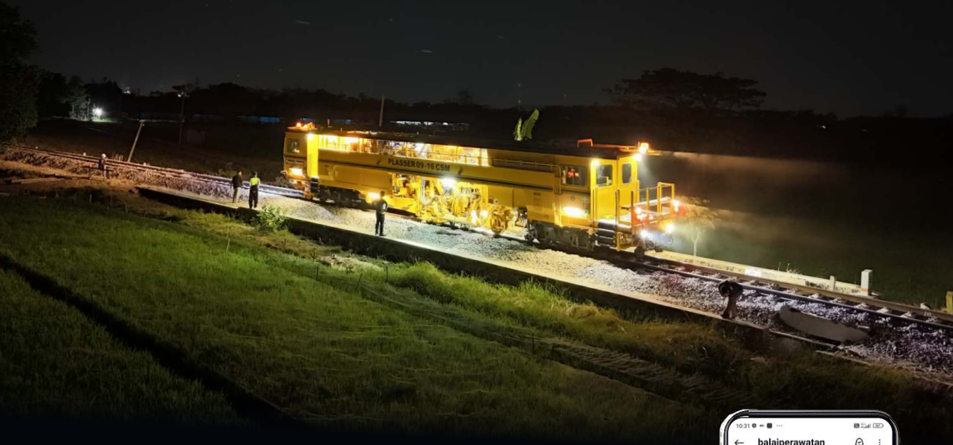
Pengoperasian Multi Tie Tamper untuk pemecakan jalur rel kereta api di lintas Solo-Wonogiri
